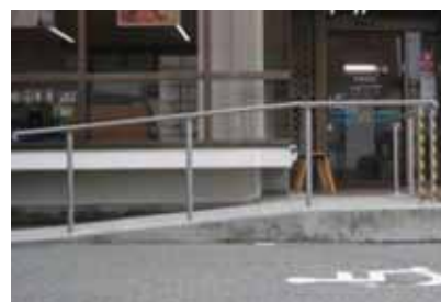
スロープ設置によるバリアフリー化
